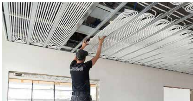
Der Installateur befestigt die Heiz- und Kühlelemente an herkömmlichen Unterkonstruktionen, wie sie aus dem Trockenbau bekannt sind.
