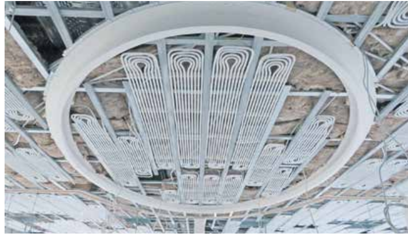
Die Strahlungs-kühldecke Thermatop M bietet vielfältige Gestaltungsmöglichkeiten. Foto links: Das in sich geschlossene System umfasst die Anbindung an einen Verteiler.
