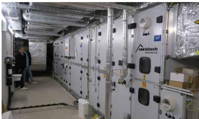
Die RLT-Anlage von Bösch versorgt den neuen Schultrakt mit einem Luftvolumenstrom von 5.910 m<sup>3</sup> pro Stunde.
