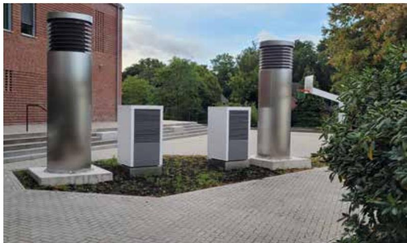
Die Außeneinheiten der BLW Neo 18 stehen auf speziellen Sockeln, die einen möglichen Körperschall verhindern.
