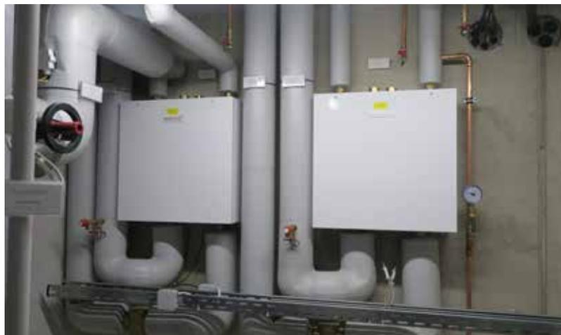
Zwei Hydro-Boxen erleichterten die hydraulische Anbindung der Wärmepumpen in das System.
