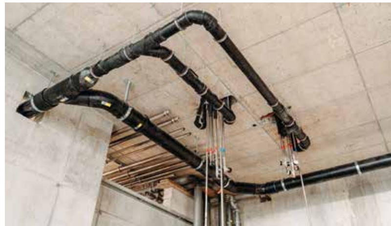
Dank der neuen Technologie gibt es keine verbotene Anschlusszone, Umgehungsleitungen werden überflüssig.
