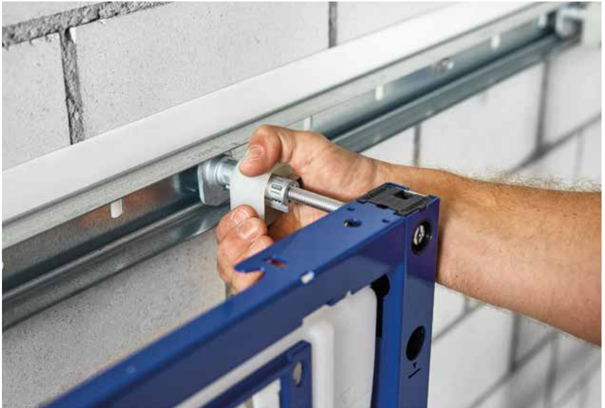
Der Wandanker lässt sich über eine 45-Grad-Drehung in der Duofix Systemschiene fixieren.
