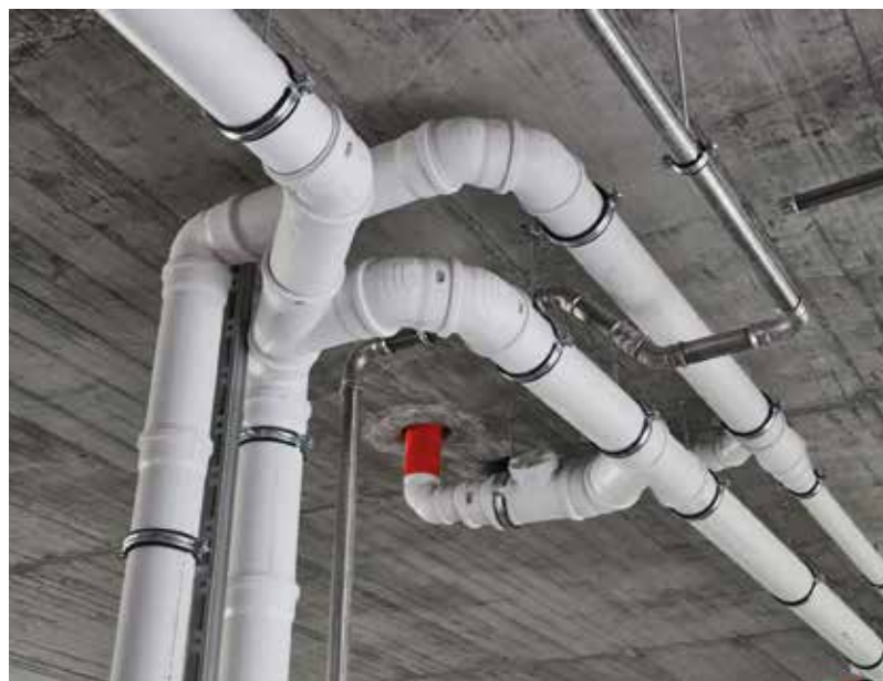
Die Abwasserrohre des Systems Raupiano Plus erfüllen höchste Anforderungen an den Schallschutz und vermeiden weitgehend störende Fließgeräusche.
