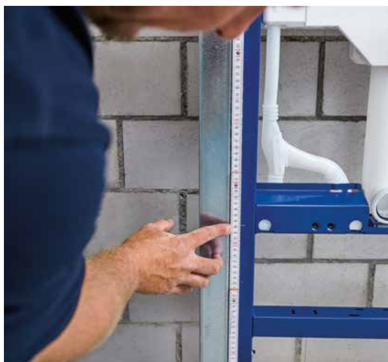
Zusätzliche Höhenmarkierungen zeigen die Mitte der Gewindestangen und des Anschlussbogens an, womit das Messen leichter fällt.
