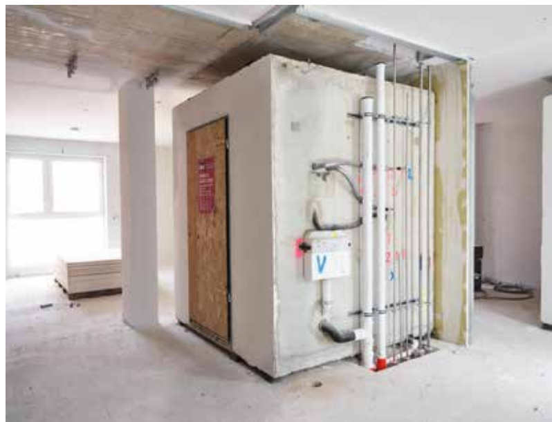
Auf einer Wandseite der Fertignasszellen sind die Anschlüsse vorbereitet, sodass sie mit wenigen Handgriffen an die Hauptversorgungsleitungen angeschlossen werden können.
