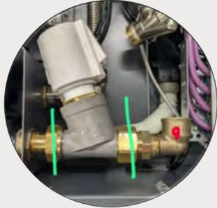
Geringer Platzbedarf für druckunabhängige Regelventile in Gebläsekonvektoren
