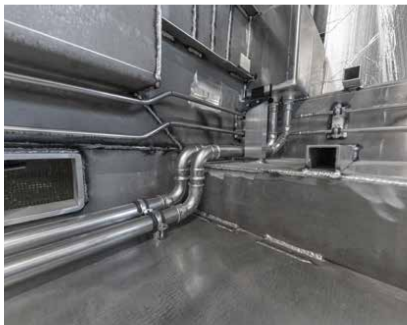
Bild oben und Mitte: Im Schiffsrumpf werden die Mapress Leitungen für die Heizung und Kühlung verlegt, bevor der Innenausbau beginnt.
