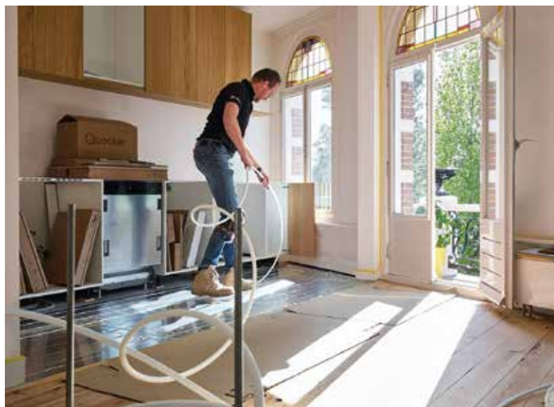
Ein Vorteil des Fußbodenheizungssystems ist die einfache Ein-Mann-Verlegung.
