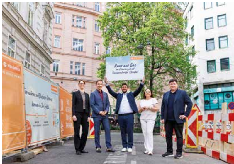
Die Gumpendorferstraße ist eines der Pioniergebiete des Fernwärmeausbaus in Wien.
