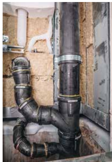
Auch in der verbotenen Anschlusszone im untersten Geschoss ist keine Umgehungsleitung für den Fallstrang notwendig.
